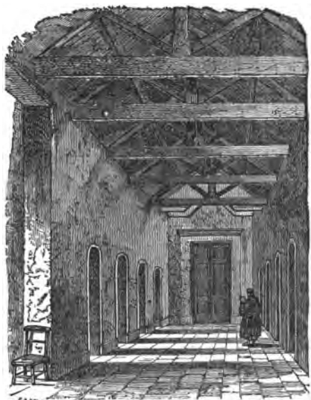
Corridor in San Marco.
